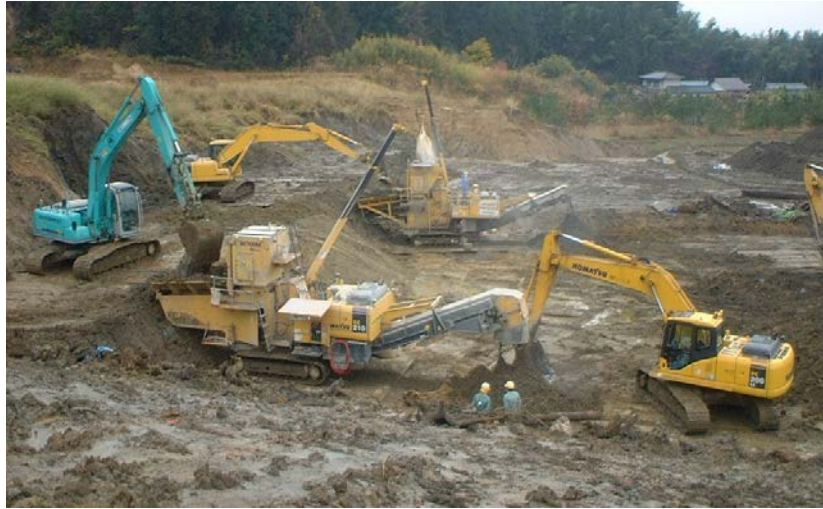
施工状況(平成16年 能代川)
