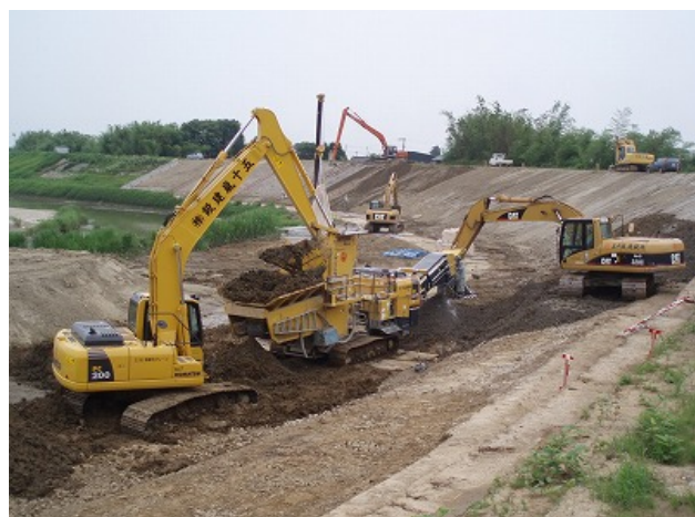
写真-3 改良状況
