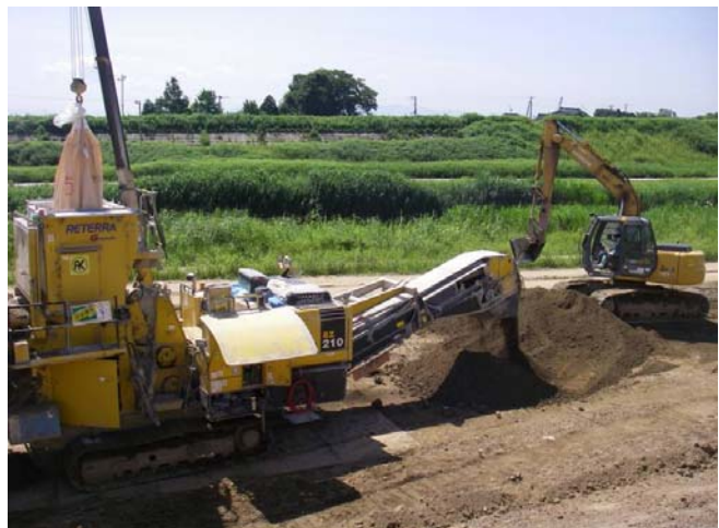
写真-2 改良状況
