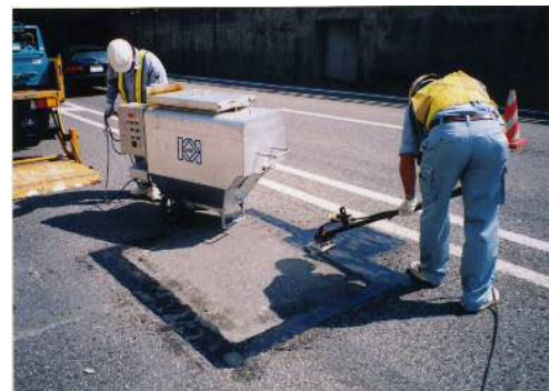
施工状況(ファルコンHR)
