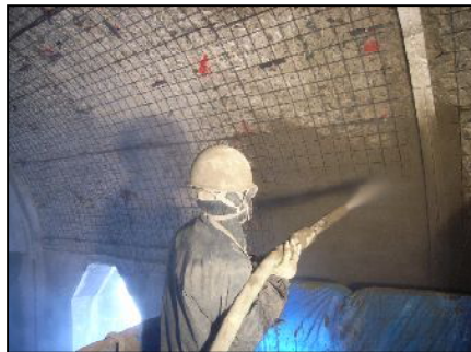
乾式吹付け状況
