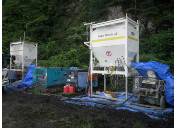
プラント設置状況
