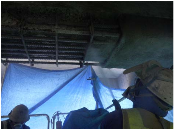
乾式吹付け状況
