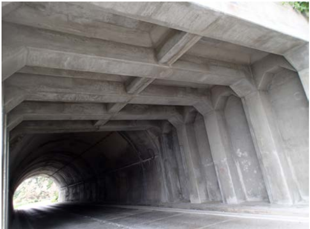
乾式吹付け完了
