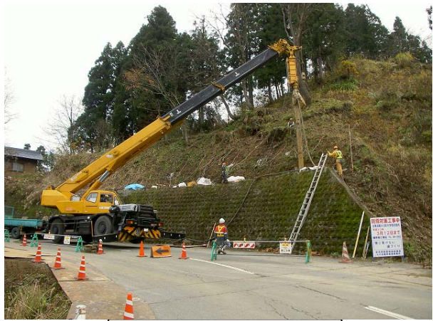
大口径ホーリング工
