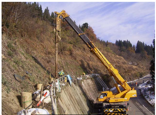
大口径ホーリング工
