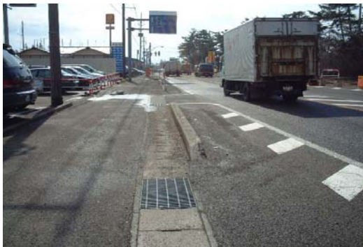
写真-3 国道乗入れ部・道路側溝(Ⅱ型)
