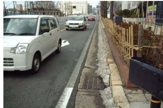
写真-2 国道車道部の街渠柵(Ⅲ型)
