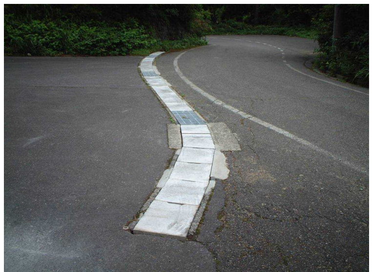
グレーチングストッパー(タイプNⅡ型)取付け状況(全景)
