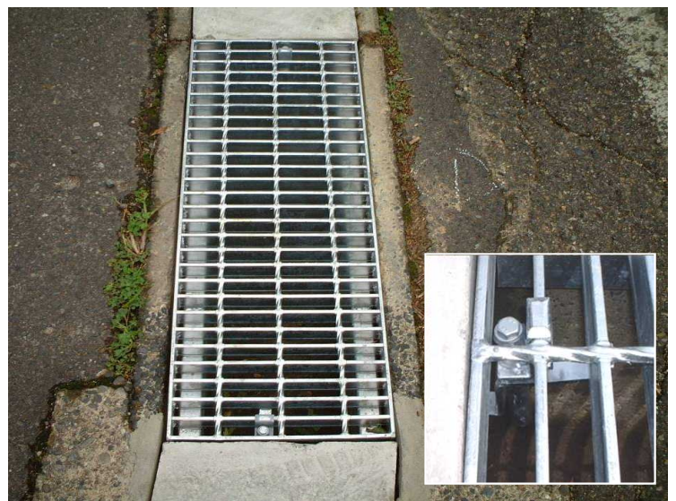
グレーチングストッパー(タイプNⅡ型)取付け状況(近景)
