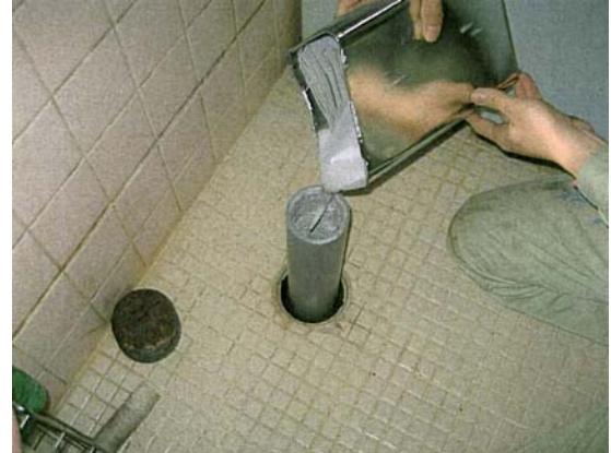
吸引によるライニング(排水管)
