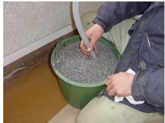
研磨状況(給水管)
