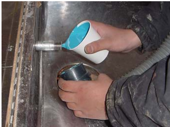
吸引によるライニング(給水管)
