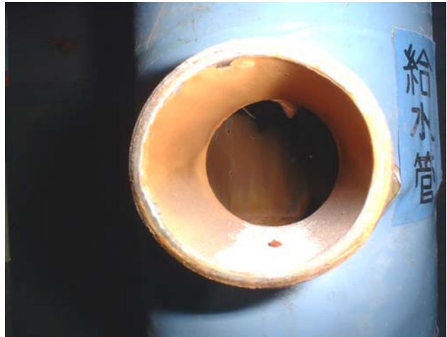
施工前 既存配管内部
