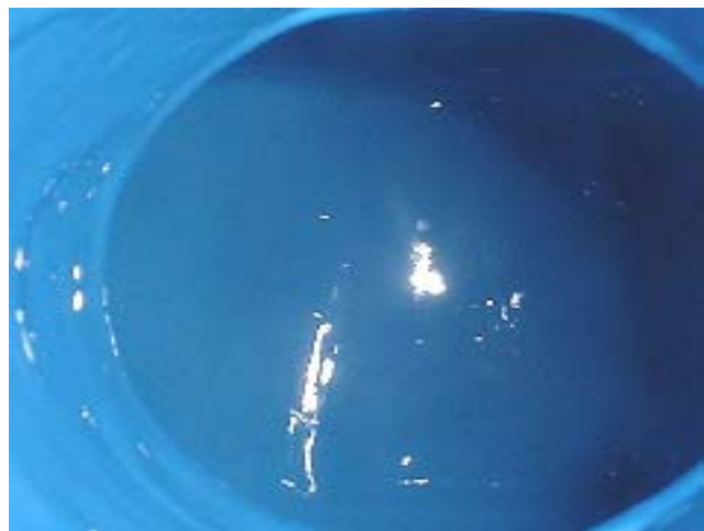
ライニング後 配管内部
