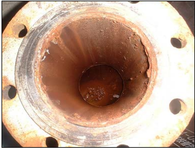
施工前 既存配管内部
