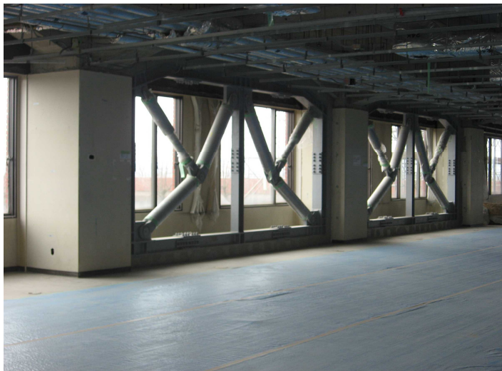
増幅機構付油圧制震ブレース装置 取付完了写真(遠景)
