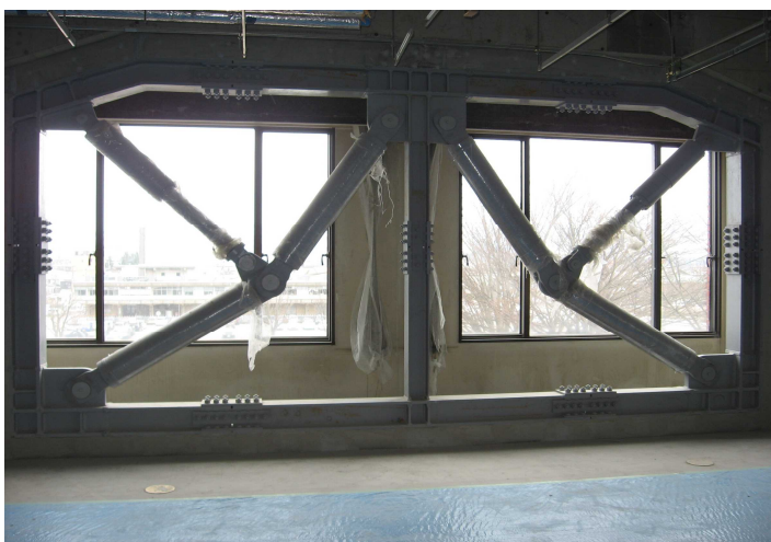
増幅機構付油圧制震ブレース装置 取付完了写真(近景)
