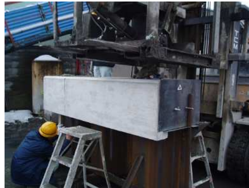
試験施工状況
