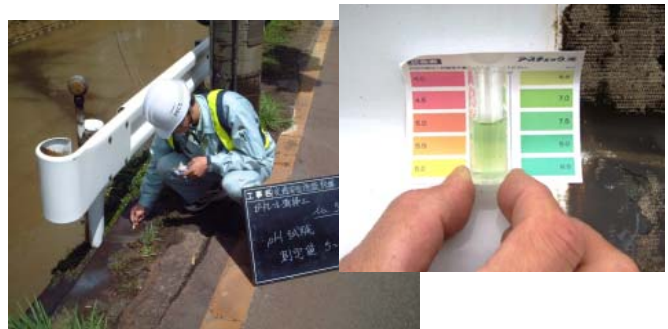
④排水のpH測定(中性域アルカリ性側であること)
