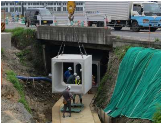
製品据え付け・調整
