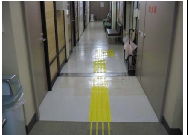
⑥ミラクルコーティング処理施工後
