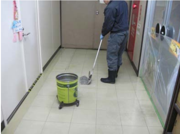
③既存ワックス剥離作業
