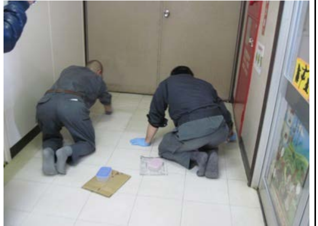
④プライマー及びコーティング剤塗布作業
