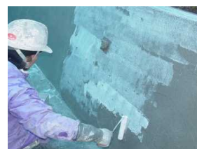
被覆養生材塗布
