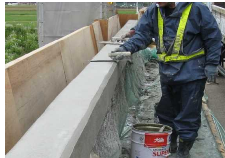
左官工法による施工状況
