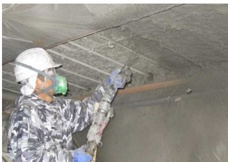
吹付け工法による施工状況
