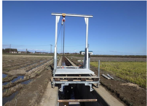
設置状況(全景)
