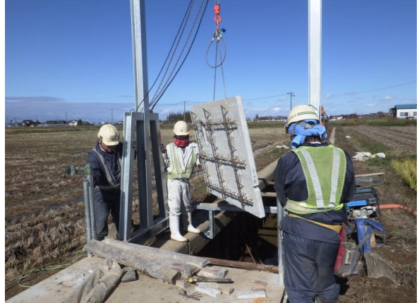
吊上げ作業状況
