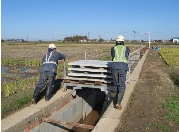
運搬作業状況
