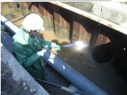
下地処理工(高圧洗浄)
