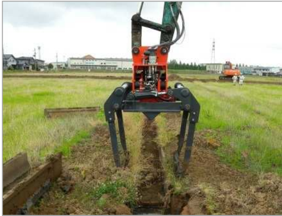
微振動によるクランプ挿入
