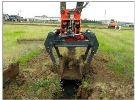
側溝の抱込み状況
