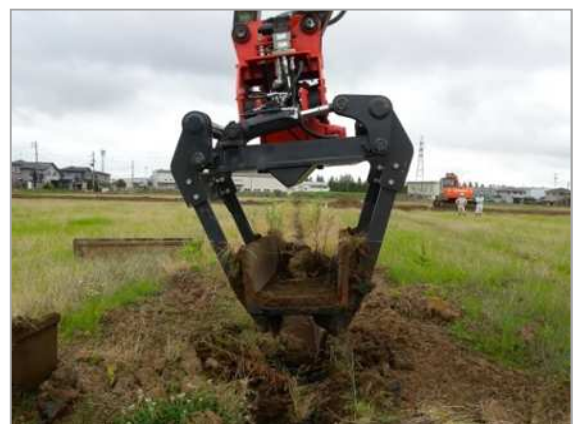
側溝の引上げ状況
