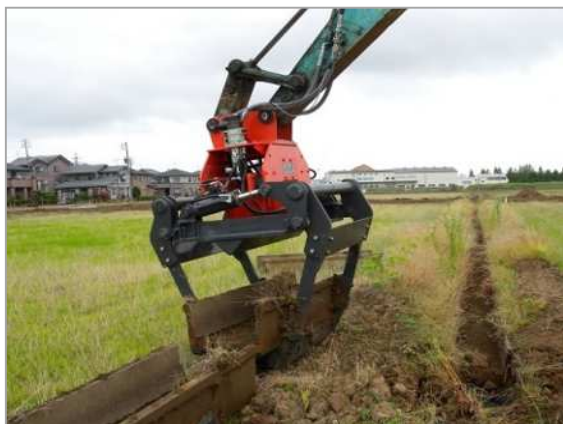
側溝の撤去・仮置き状況
