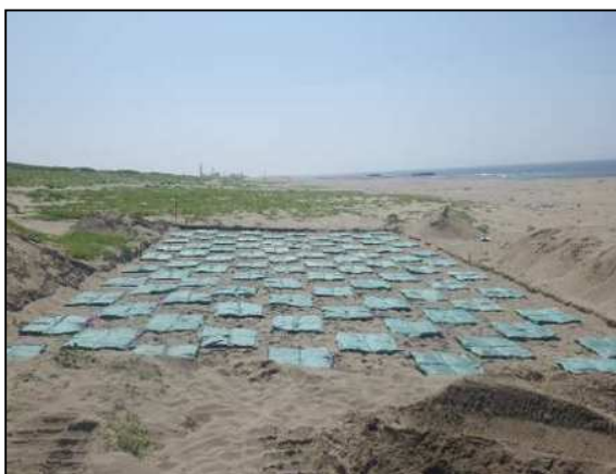
平成26年6月 施工(マット配置完了)
