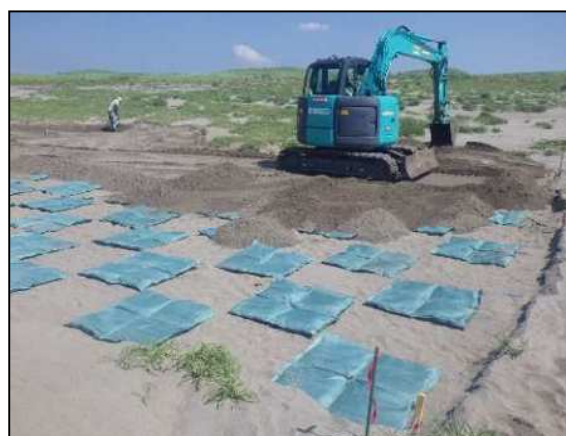
平成26年6月 施工(現地砂埋め戻し)
