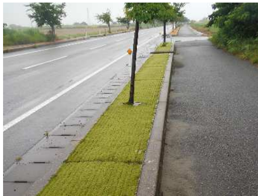
施工後(1年半経過)
