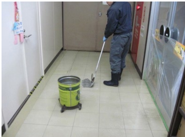
③既存ワックス剥離作業
