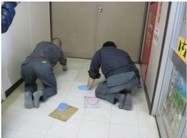
④プライマー及びコーティング剤塗布作業
