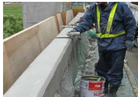
左官工法による施工状況
