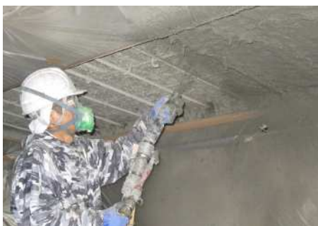
吹付け工法による施工状況
