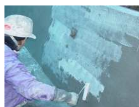
被覆養生材塗布
