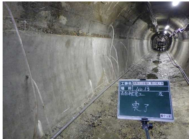
写真-1) 韌性モルタルNA施工完了(表面被覆工)
