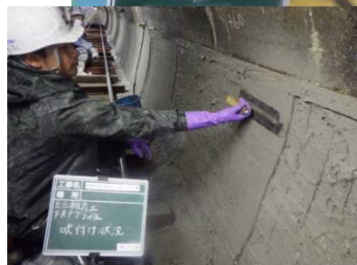
写真-2) 韌性モルタルNA 施工状況
