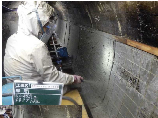
写真-1) 韌性モルタルNA施工完了(表面被覆工)
