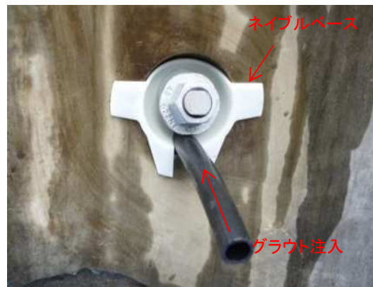
↑ グラウト注入時の孔口の状況
