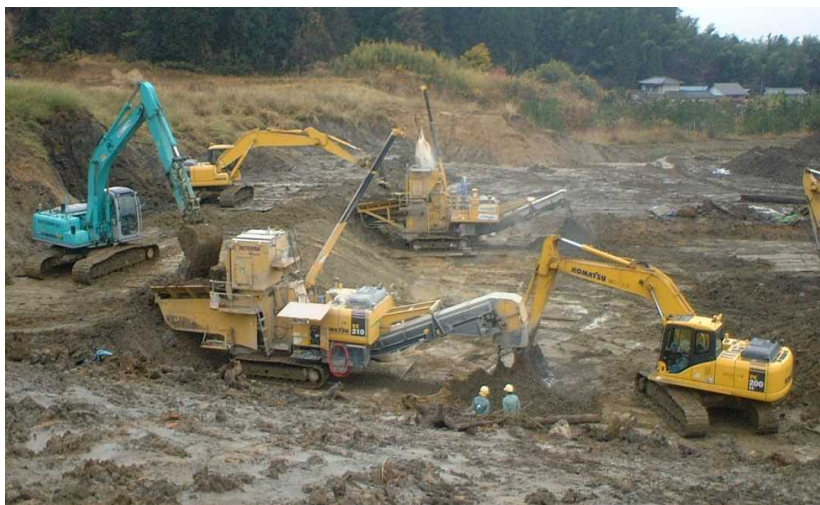
施工状況(平成16年 能代川)
