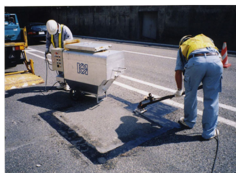
施工状況(ファルコンHR)
