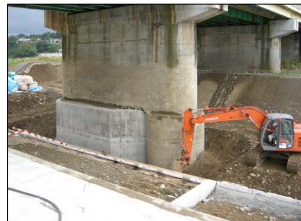
写真-3 改良土埋戻し状況
