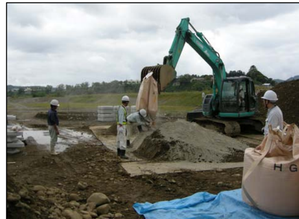
写真-2 固化材混合状況
