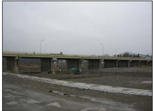
写真-1 現場全景
