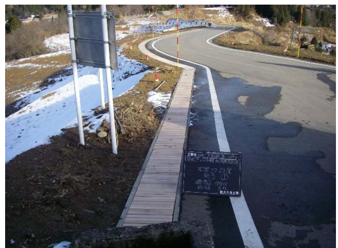
施工状況(遠景)
