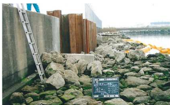
鋼矢板プレボーリング(捨石層)
