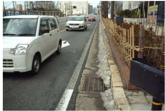
写真-2 国道車道部の街渠柵(Ⅲ型)
