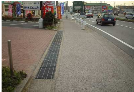
写真-1 国道乗入れ部・道路側溝(Ⅰ型+Ⅱ型)
