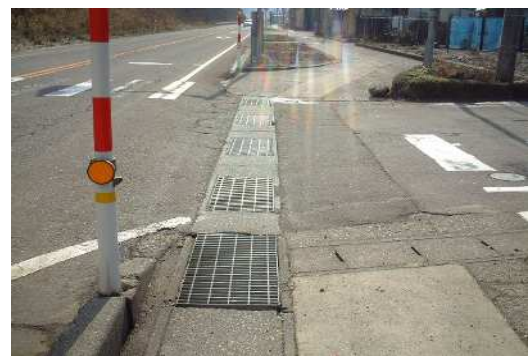
写真-4 国道と町道交差点部・横断側溝(Ⅱ型)
