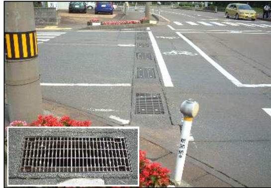
写真-4 県道・横断側溝ボルト固定の代用
