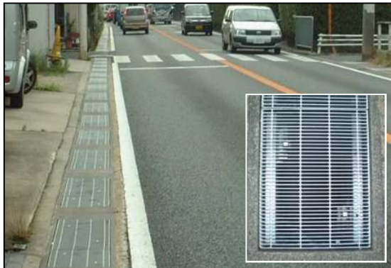
写真-3 国道・道路側溝細目グレーチング設置例
