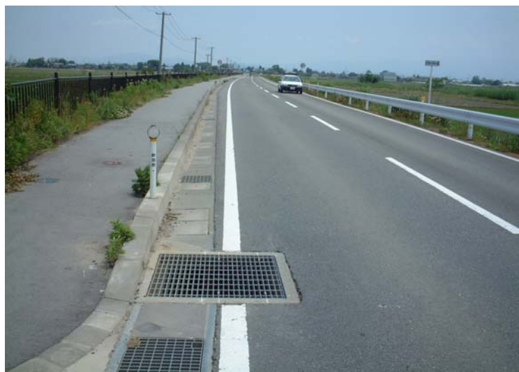
グレーチングストッパーSP取付け状況(砂山・全景)
