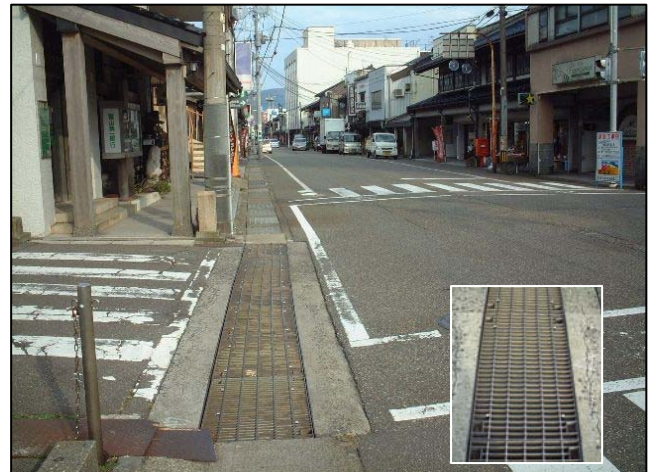
グレーチングストッパーSP(ダブル)取付け状況(全景)
