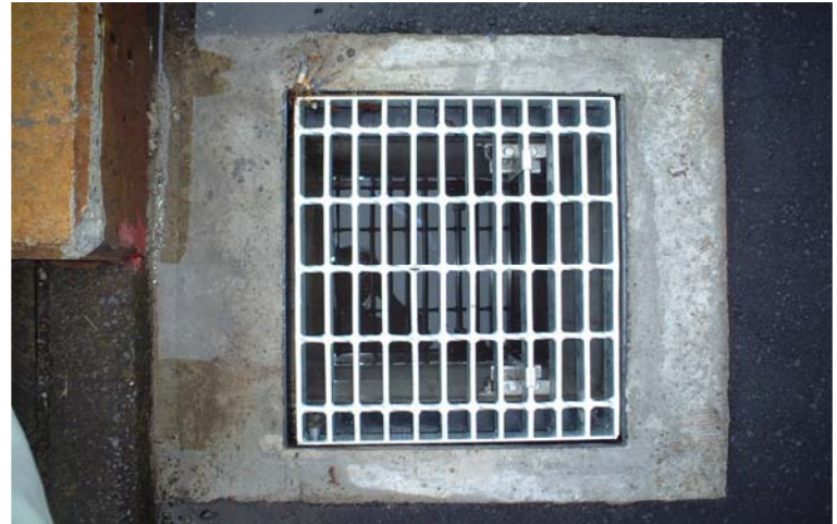
グレーチングストッパーSP取付け状況(近景)
