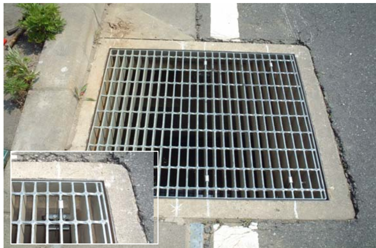
グレーチングストッパーSP取付け状況(砂山・近景)
