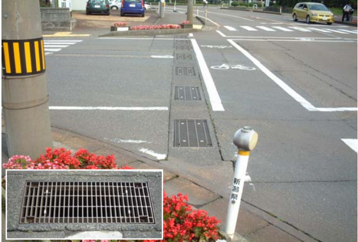
グレーチングストッパーSP取付け状況(豊町・全景)
