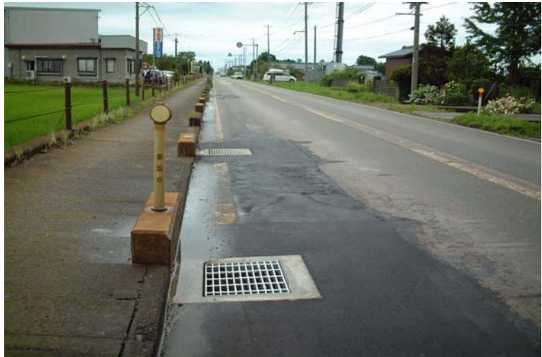
グレーチングストッパーSP取付け状況(全景)
