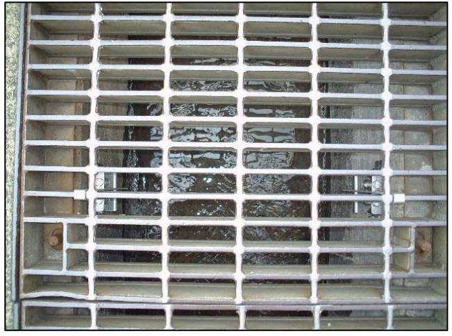
グレーチングストッパーSP(ダブル)取付け状況(近景)
