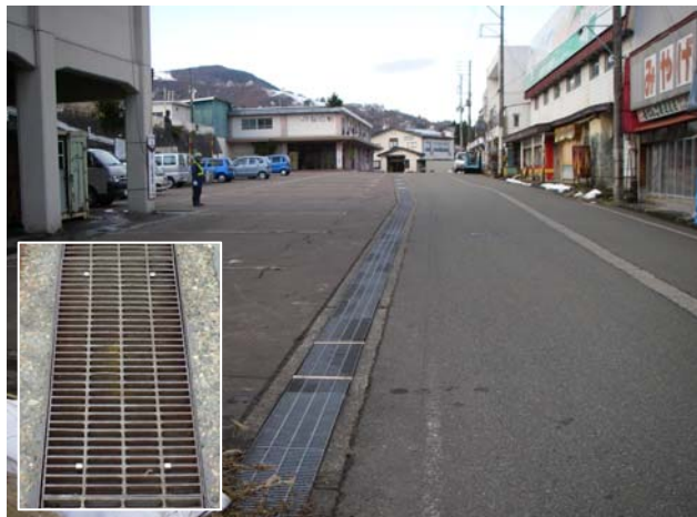
グレーチングストッパーSP(シングル)取付け状況(全景)
