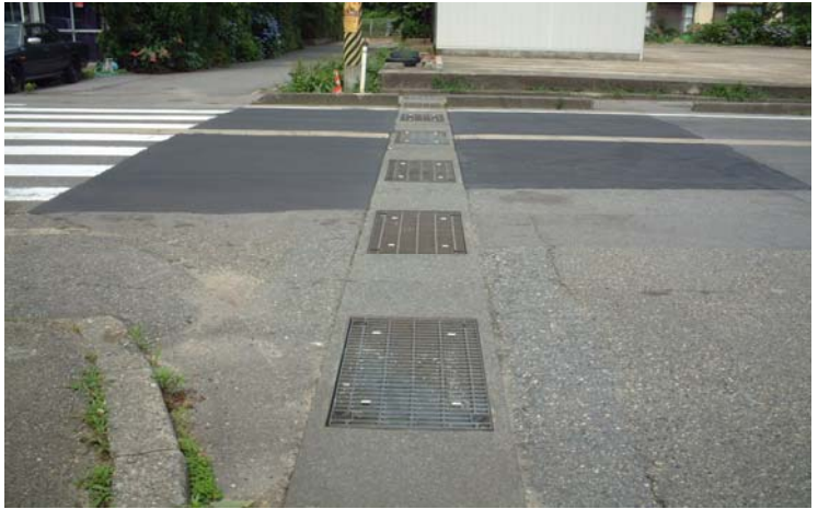
グレーチングストッパーSP取付け状況(五十公野・全景)
