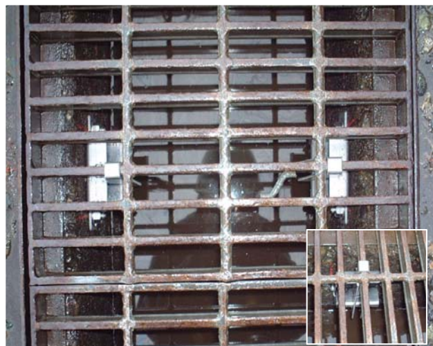
グレーチングストッパーSP(シングル)取付け状況(近景)
