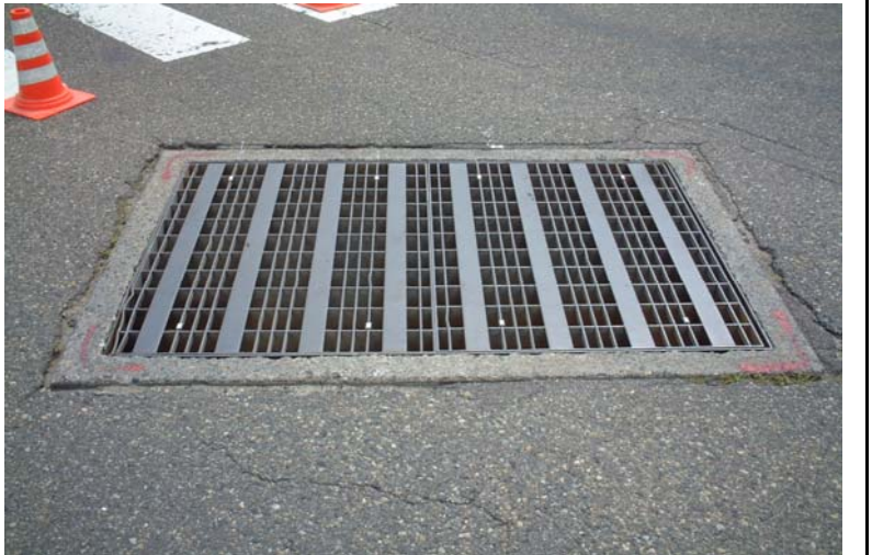
グレーチングストッパーSP取付け状況(則清新田・全景)
