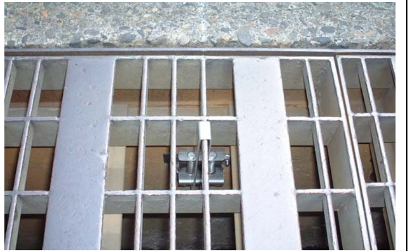
グレーチングストッパーSP取付け状況(則清新田・近景)
