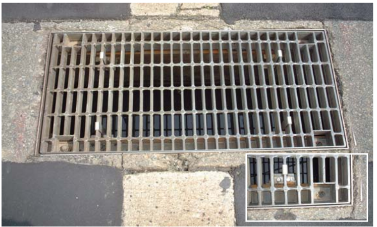
グレーチングストッパーSP取付け状況(五十公野・近景)
