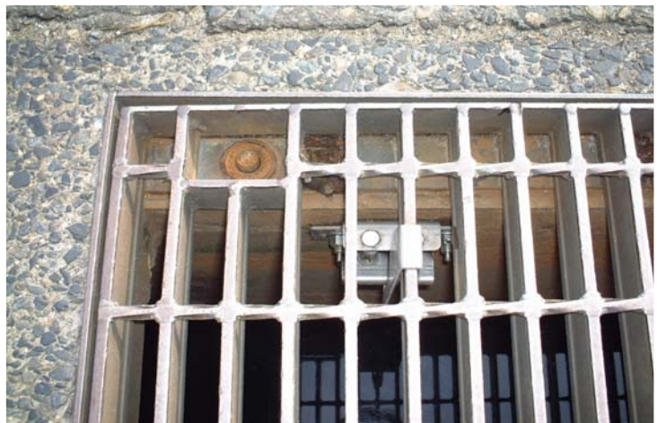
グレーチングストッパーSP取付け状況(豊町・近景)
