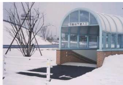
地下道入り口(長岡市)
