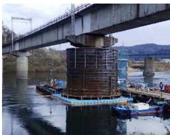
仮締切り設備吊降し前全景
