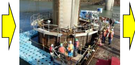
仮締切り設備吊降し状況
