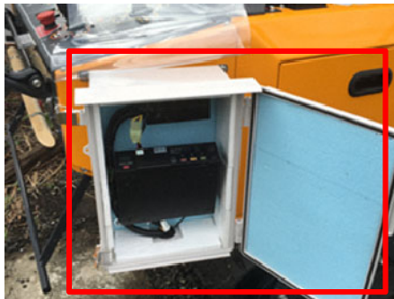
③IoTセンサーの防水ボックス取付け状況
