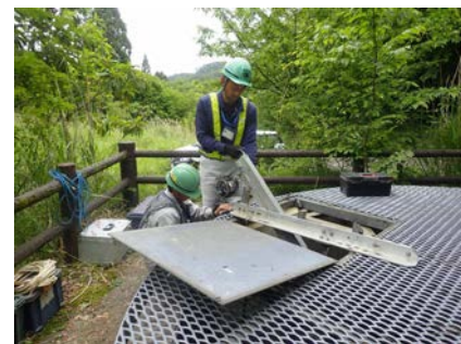
専用架台の設置状況
