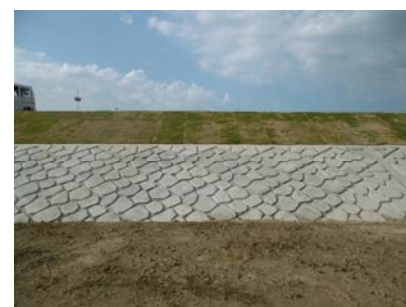
③施工完了
