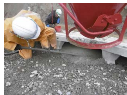
②胴込めコンクリート打設
