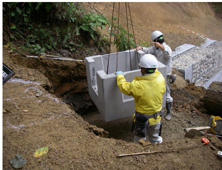
工程2: 集水枡据付
