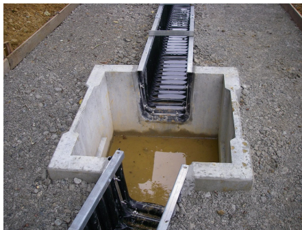
工程4: 埋め戻し完了
