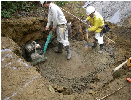
工程1: 碎石転圧
