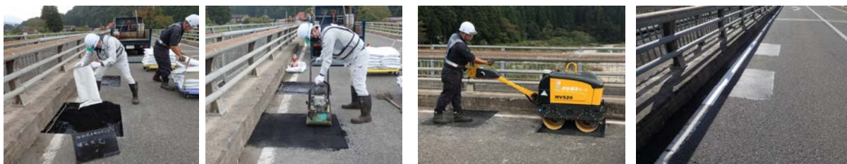
①Eco路面リペア敷均し
