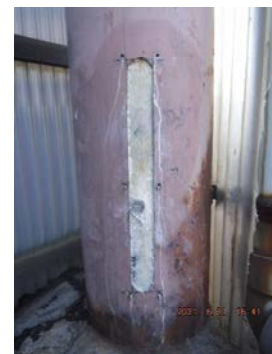
タイプs施工後
