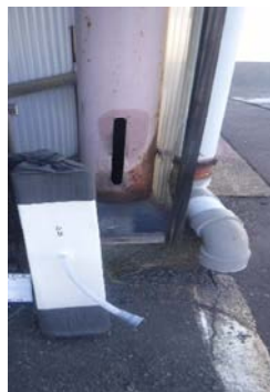
タイプs施工前
