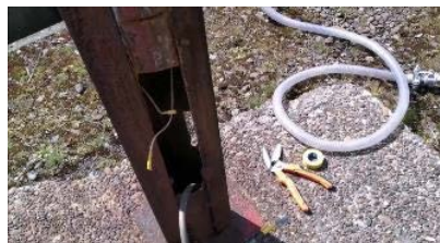
タイプT施工前
