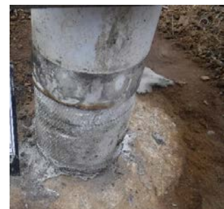
タイプG施工後
