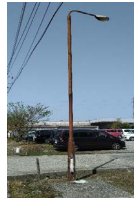
タイプT施工後
