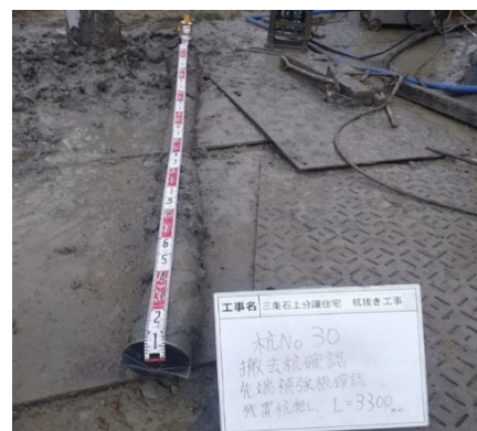
図-4 撤去した既設杭の一例
