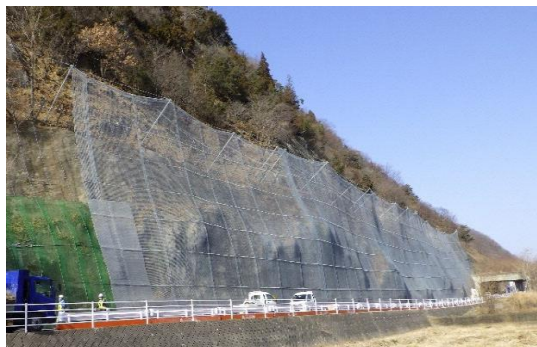
施工事例(ネットタイプ KB-NH4.0-1型)
