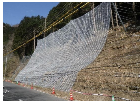
施工事例(ロープタイプ KB-RS5.0)
