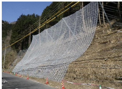
施工事例(ロープタイプ KB-RS5.0)
