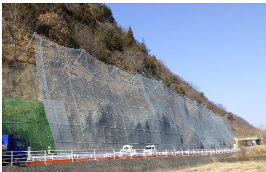
施工事例(ネットタイプ KB-NH4.0-1型)
