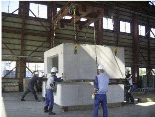
※上部と下部をドッキングした際の品質確認 (可変型集水枡 2500×2500×2000:2分割)
