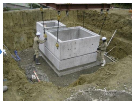
2) 集水枡＋可変型集水枡を設置
