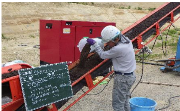
③吹付資材投入
