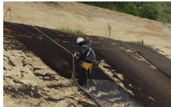
④吹付状況
