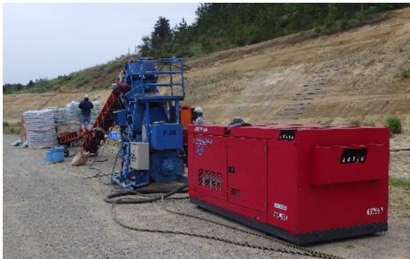
①資材搬入、吹付機械セット
