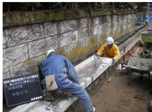
写真-2 リペアリッド据付
