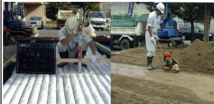
試験ヤードでの敷設・転圧状況
