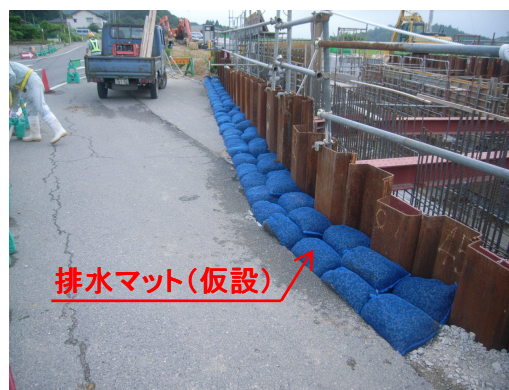
排水マット敷設後
