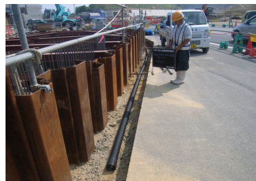
排水マット敷設前
