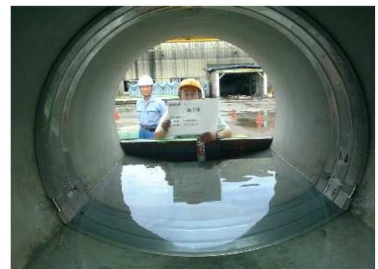
3. マグマロック設置工：設置完了
