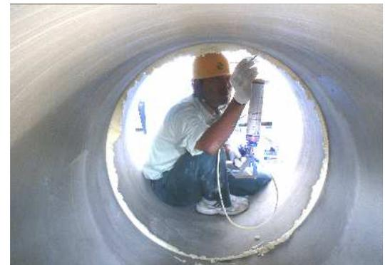
2. シール材充填工：誘導目地切削後シール材充填
