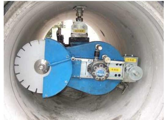
1. 誘導目地設置工：誘導目地切削機による切削
