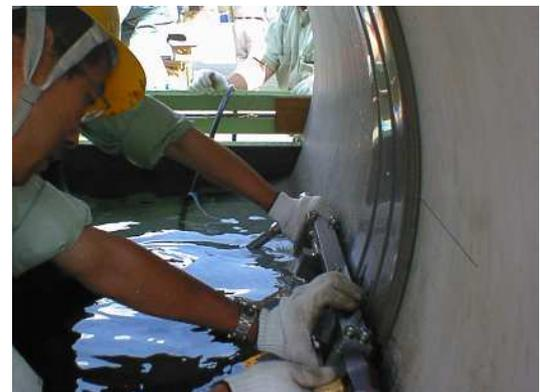
3. マグマロック設置工：専用ジャッキによる固定作業
