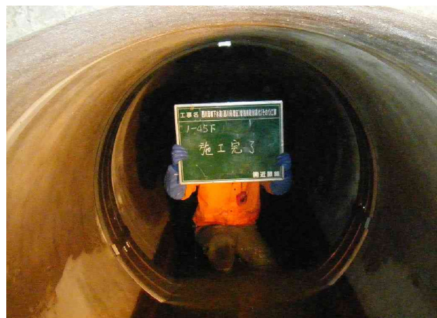
写真. 2 マグマロック設置⇒施工完了
