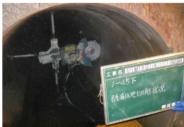
写真. 1 誘導目地切削状況
